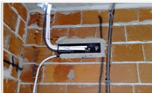
Exemplo de Instalação de caixa polar com saída de dreno lateral
