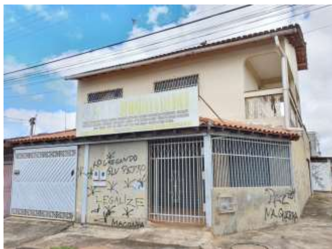
Foto 4 – Vista Geral Casa – Esquina
