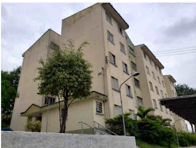
Foto 1 – Fachada- Bloco A
