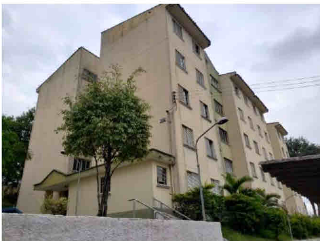
Foto 1 – Fachada- Bloco A
