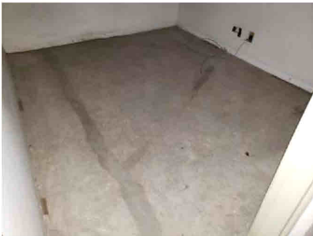
Foto 15 – Acabamento do piso e rodapé foi retirado
