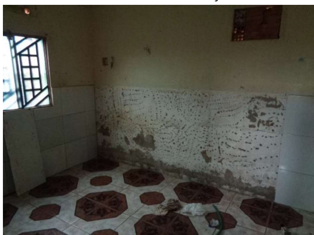
Foto do quarto com cerâmica retirada da parede
