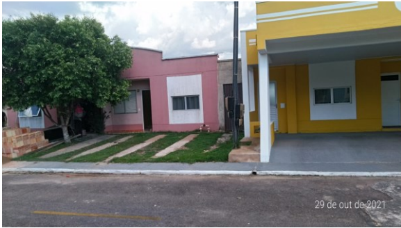
Foto 01 – Frente Principal do imóvel avaliando
