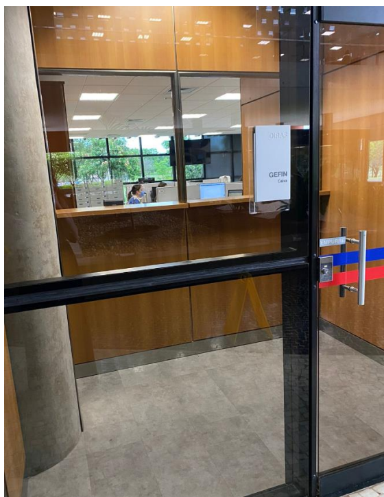
Divisórias a retirar
