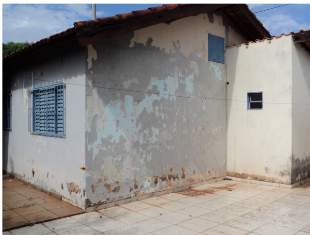
Foto 18 – Vista da fachada do fundo casa
