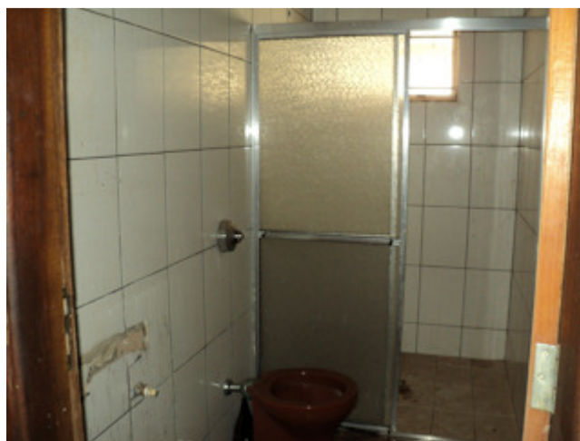
Foto 16 – Vista do banheiro da edícula
