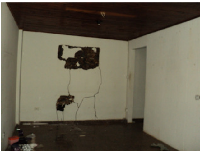
Foto 13 – Vista da sala da edícula
