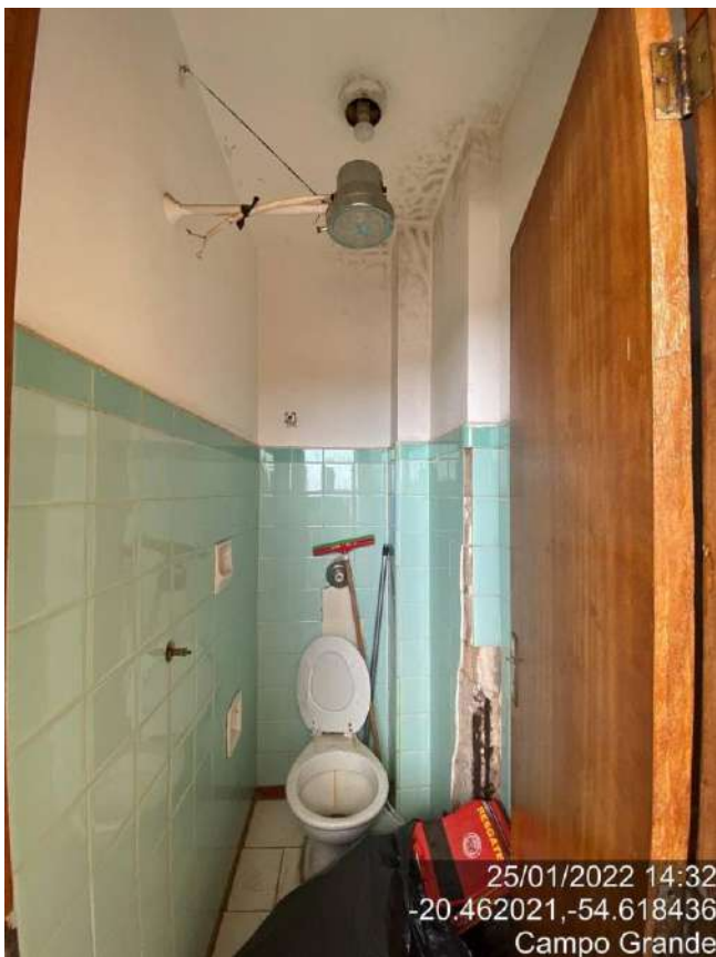
Foto 11– banheiro de serviço
