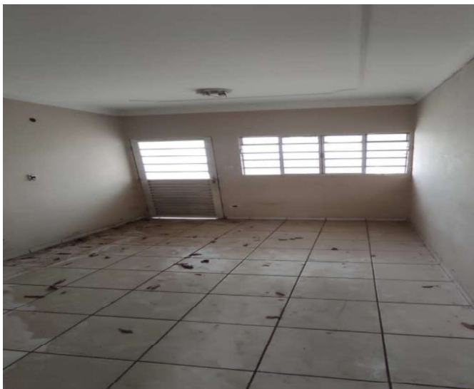
Foto 3 - Sala de Estar
