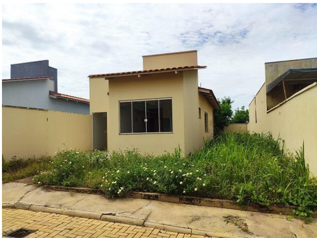
Foto 3 – Vista da fachada da unidade 05
