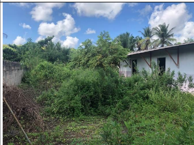
Foto 5 – Vista dos fundo do imóvel
