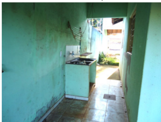
Foto 6 – Vista da área de serviço
