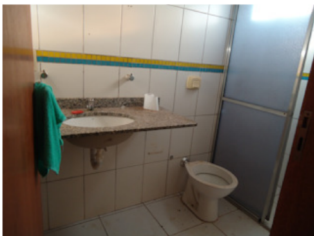
Foto 5 – Vista do banheiro
