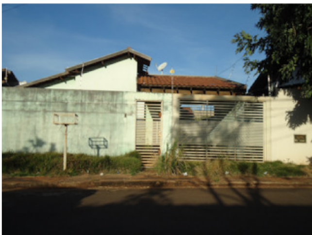
Foto 1 – Vista da fachada.
